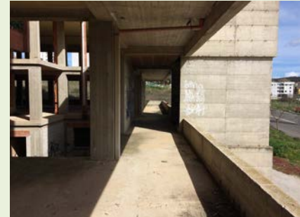
Ballatoio collegamento edifici
